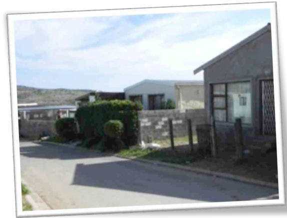
Das „neue“ Pflege-Haus in der Mitte des Bildes
